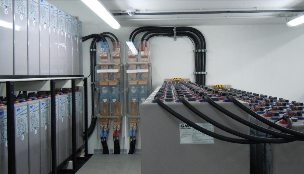
Überschüssiger Strom soll in einen Energiespeicher fließen, der die nötigste Versorgung des Gebäudes und der Arbeitsplätze im Falle eines Netzausfalls unterbrechungsfrei sicherstellt (siehe Energieschema auf der folgenden Seite).
